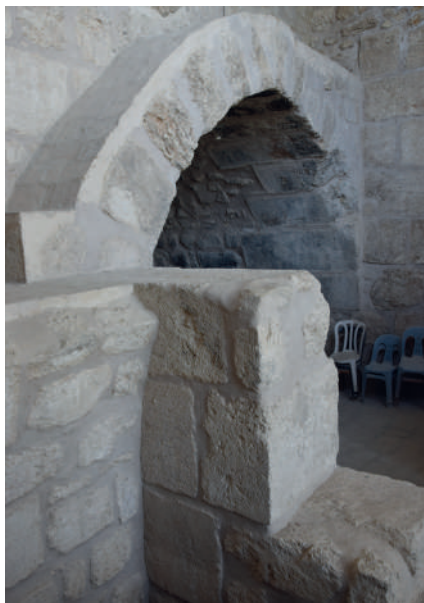
Sopra: la sottostruttura ad arco che sosteneva la navata sud della quarta chiesa. In basso: ricostruzione della quarta chiesa, sullo sfondo si vede la torre del monastero.
