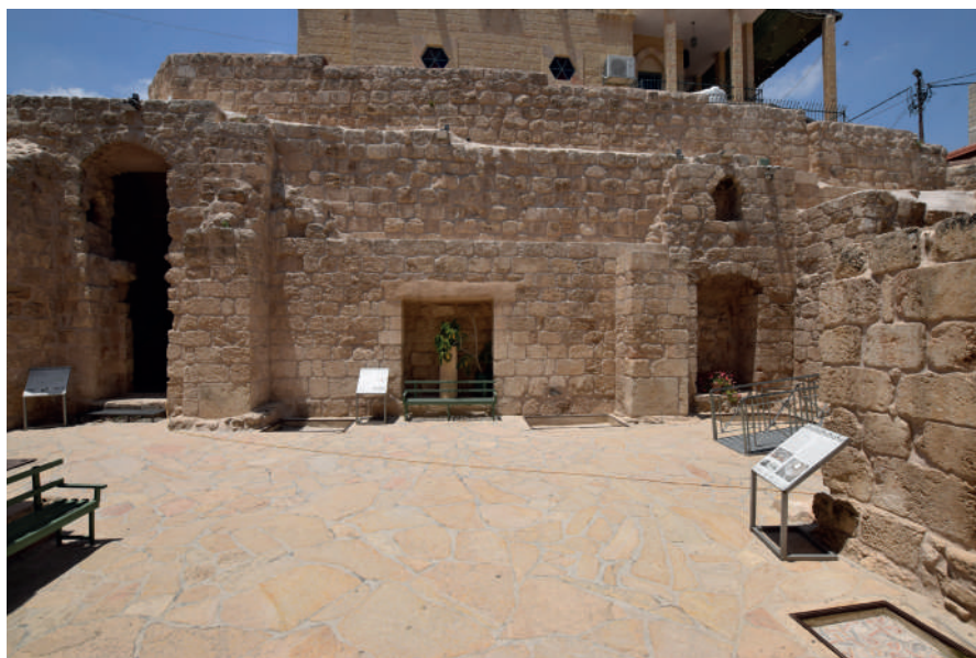
Sotto: resti della facciata della seconda e terza chiesa.
