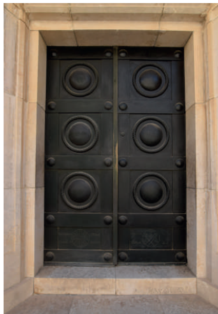
In alto: il portale della chiesa moderna.
